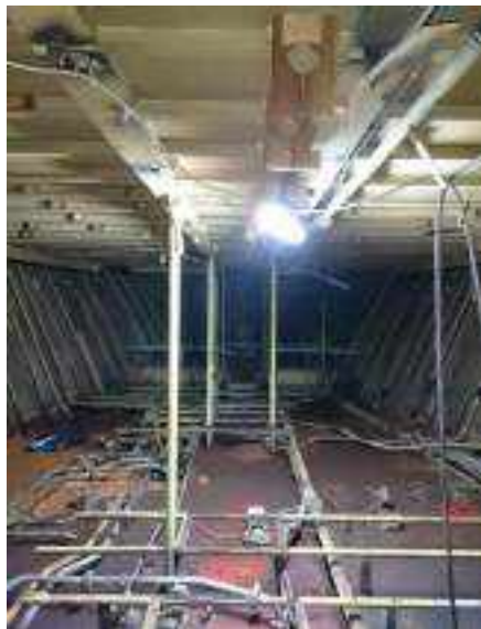
Remoción del alistamiento de los espacios interiores
