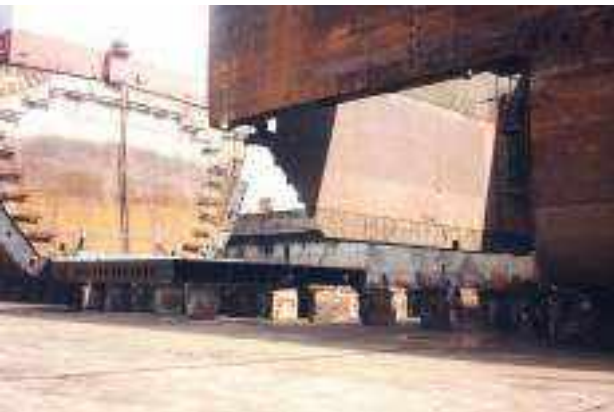
Preparación del bloque de transición
