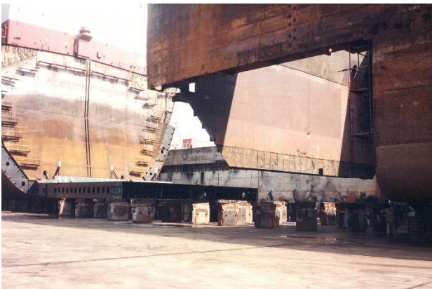
Preparación del bloque de transición
